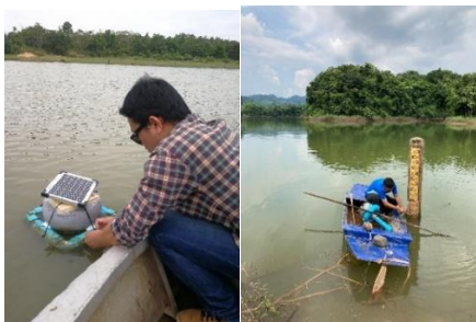
รูปที่ 17 การติดตั้งอุปกรณ์ระบบตรวจวัดระดับน้ำขนาดเล็กแบบลอยน้ำ
