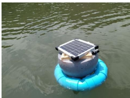
รูปที่ 18 ตัวอย่างอุปกรณ์ระบบตรวจวัดระดับน้ำขนาดเล็กแบบลอยน้ำหลังติดตั้ง
